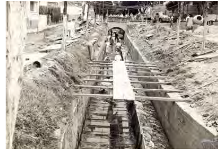
Canalização do Córrego da Servidão ruas 7 e 8, av. 6 (Cervejaria)
