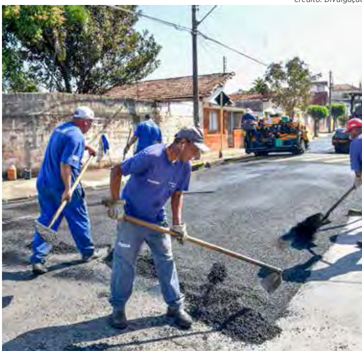
Reparo asfáltico está sendo feito em vias na Vila Nova
