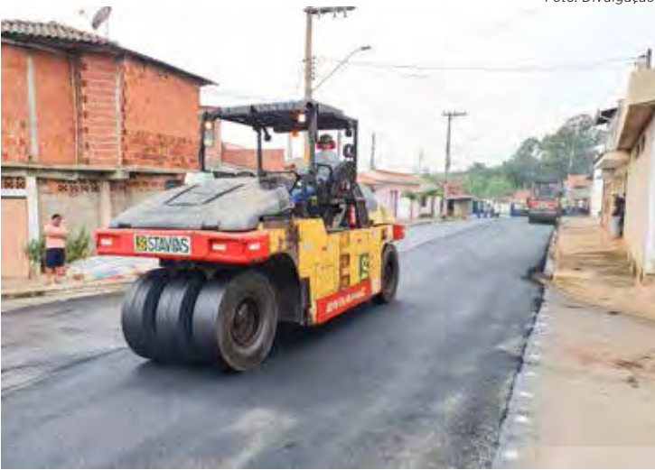
O bairro Jardim Santa Maria está recebendo obras de recapeamento
