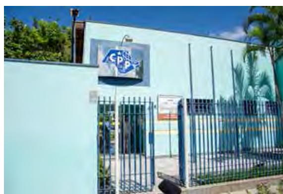
Fachada da sede do CPP na Rua 16, nº 441, o Bairro do Estádio
