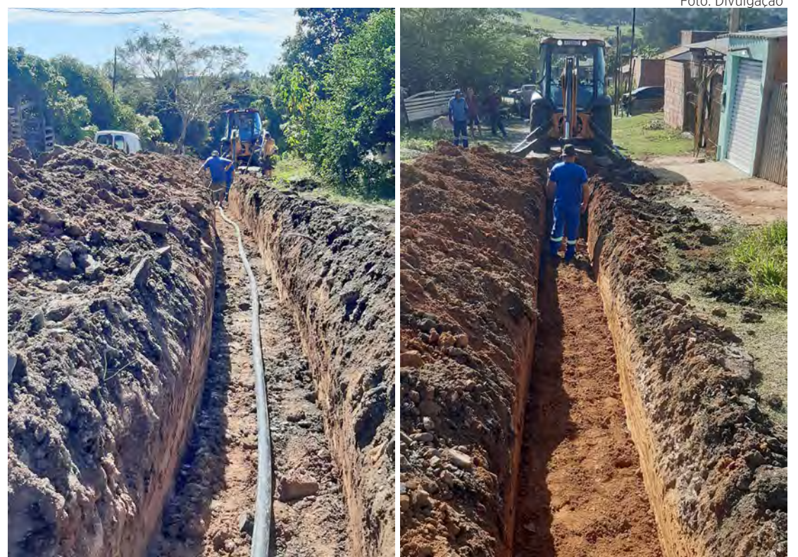
O Daae está executando a implantação de rede de abastecimento de água no Bonsucesso.
