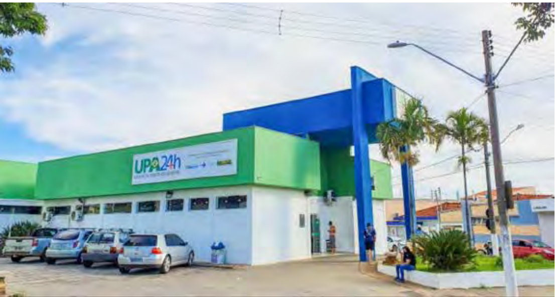
Prédio da UPA da Avenida 29 será reformado por empresa contratada pela prefeitura
