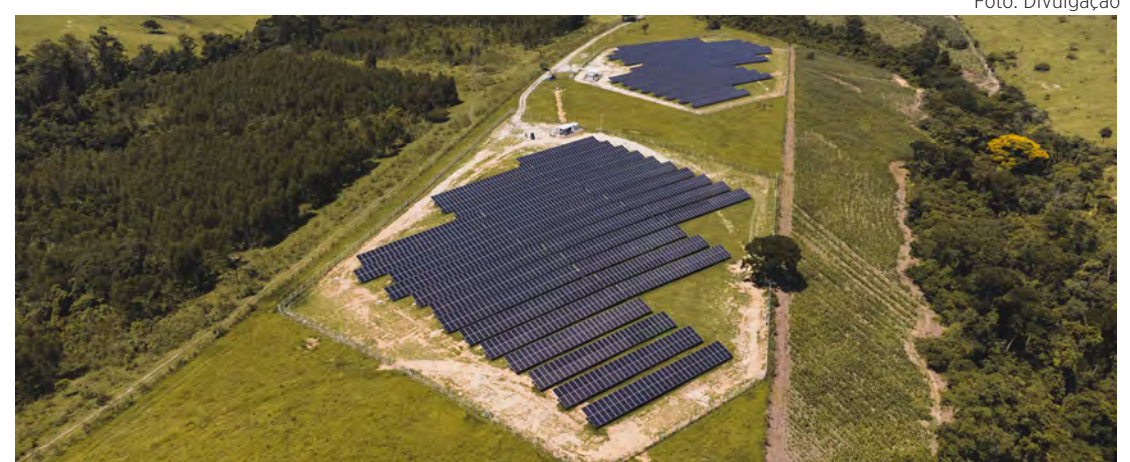
O projeto “Santa Rita” conta com três unidades de usinas fotovoltaicas
