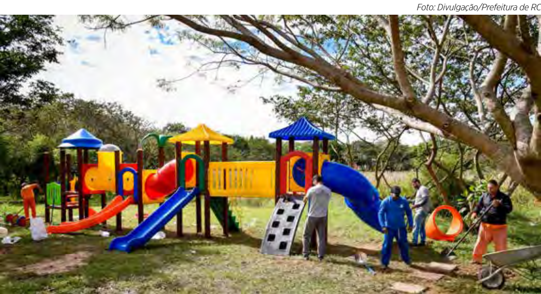
Instalação de brinquedos foi realizada nesta semana
