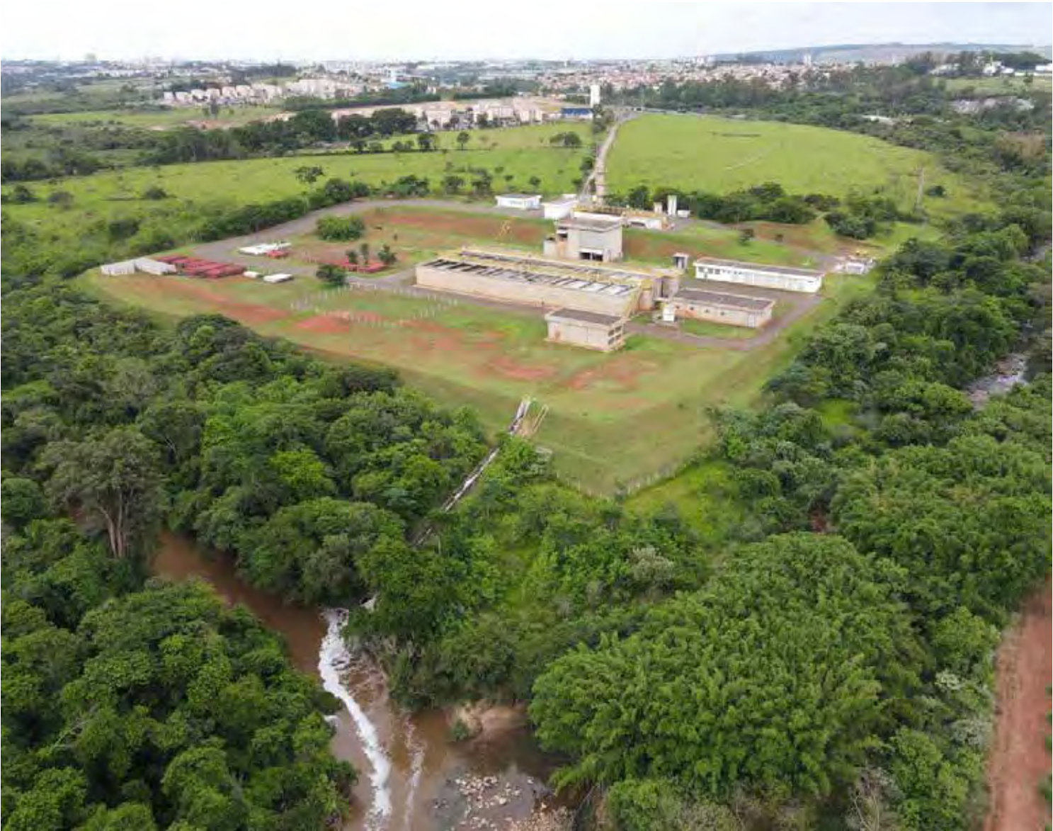
ETE (Estação de Tratamento de Esgoto) Jardim Novo em Rio Claro
