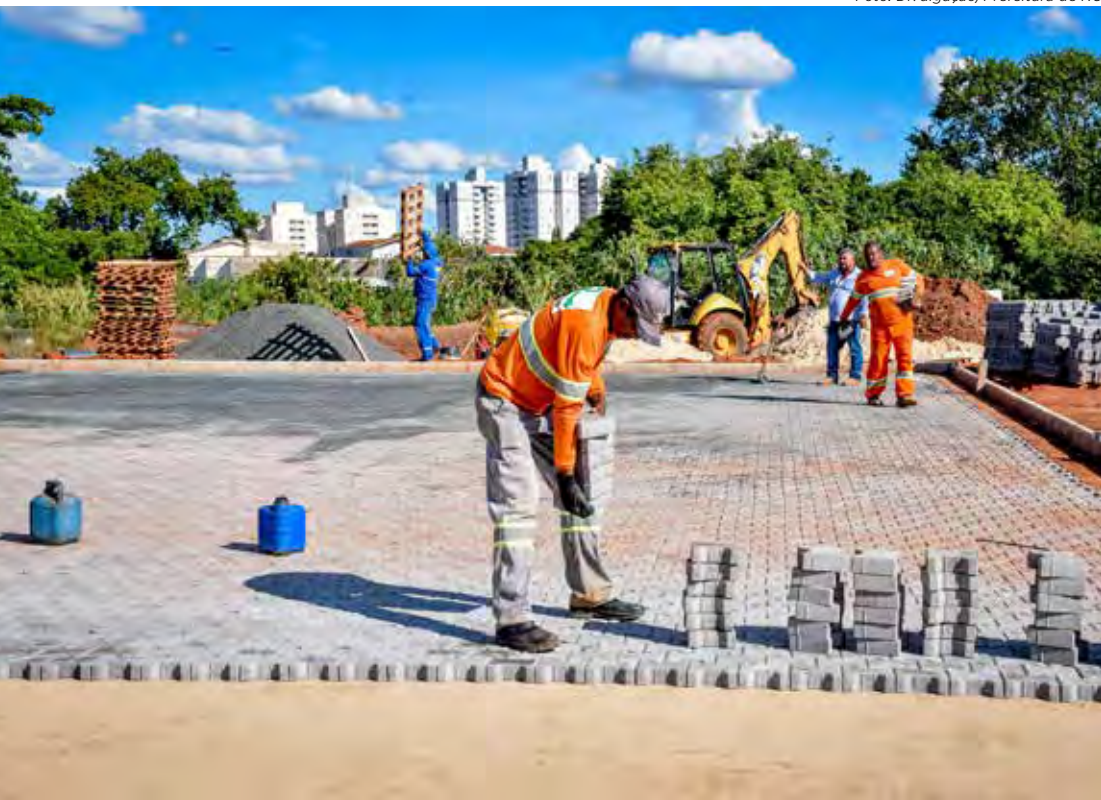
O calçamento está sendo feito com pequenos blocos de concreto, em formato geométrico irregular
