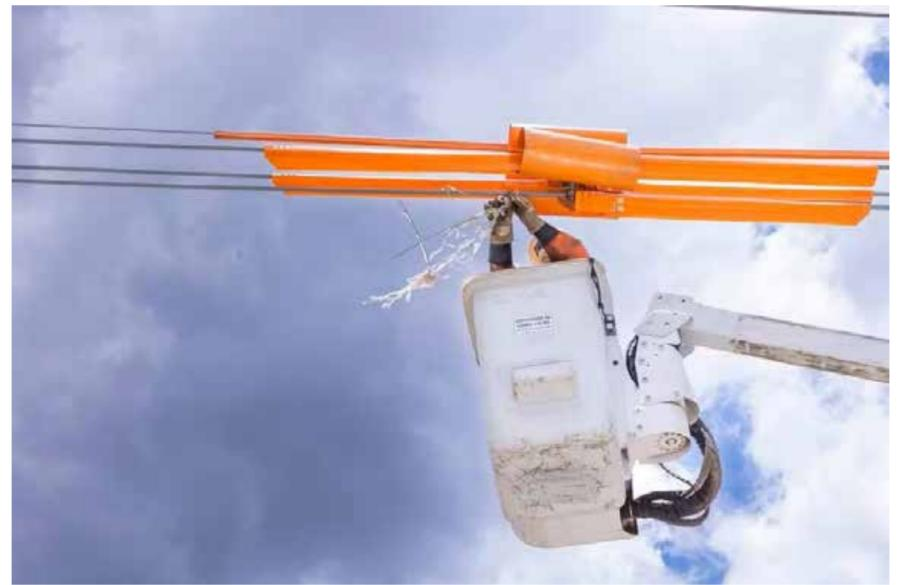
Quando a linha enrosca em postes, transformadores e nos cabos elétricos, pode provocar curtos-circuitos
