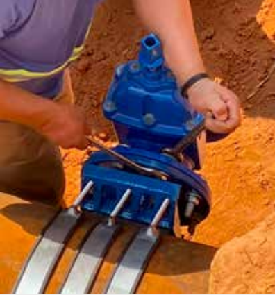
Daae executa adequação na rede que abastece a região do Jardim das Nações nesta quinta-feira
