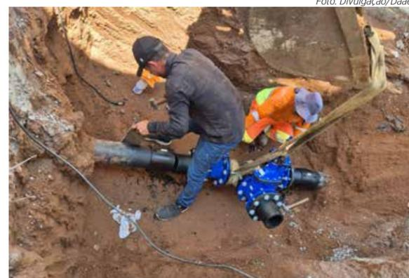
Adequação na rede está sendo feita para dar maior fluxo e vazão, melhorando o abastecimento de água
