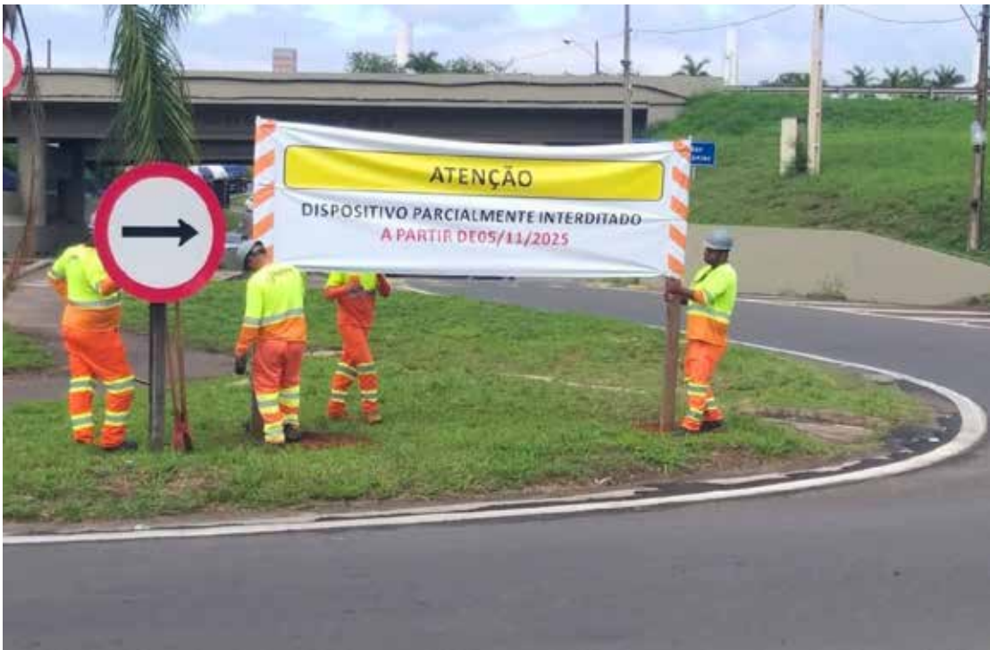
O local permanecerá devidamente sinalizado durante todo o período das obras para orientar motoristas e pedestres
