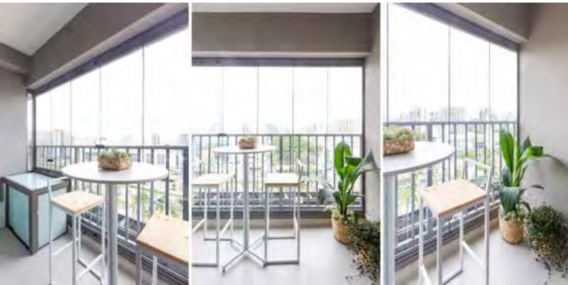
O sistema mais comum de envidraçamento usa roldanas, em que os painéis de vidro deslizam com o peso apoiado na parte superior
