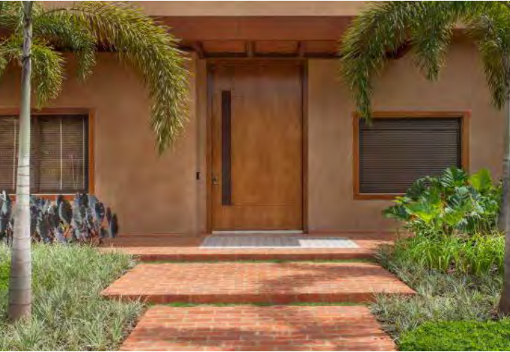
A porta de entrada antecipa o que se espera da arquitetura interior com seus diversos formatos, cores e propostas
