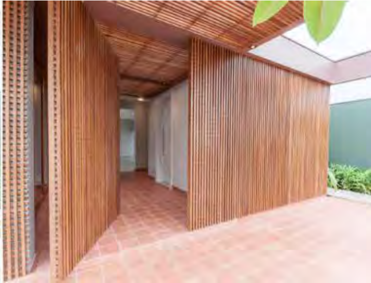
Também pivotante e mimetizada na fachada da residência, esta porta se evidencia pelo treliçado característico do muxarabi – recurso que permite a circulação de ar e entrada de ventilação natural
