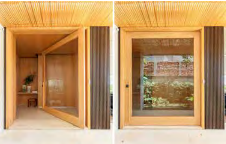
Para a arquitetura contemporânea desta residência, as arquitetas escolheram este modelo pivotante com a estrutura de madeira e vidro
