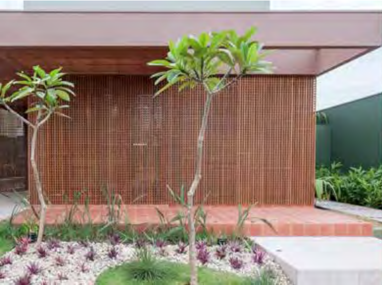
Também pivotante e mimetizada na fachada da residência, esta porta se evidencia pelo treliçado característico do muxarabi – recurso que permite a circulação de ar e entrada de ventilação natural
