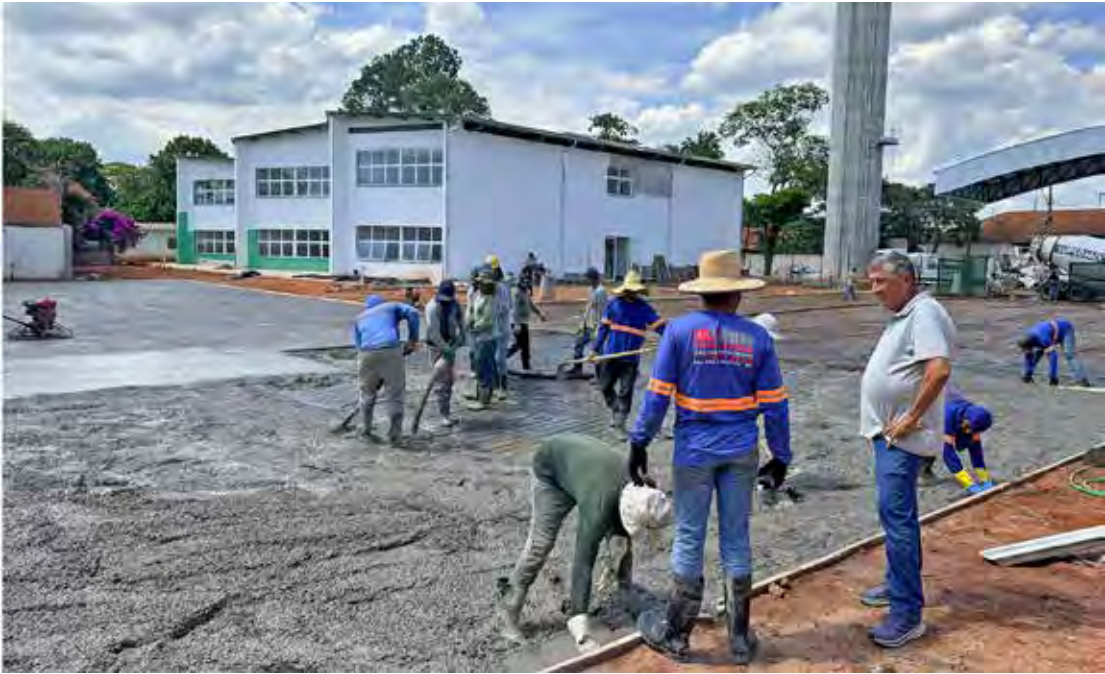
O vereador Julinho Lopes visitou o canteiro de obras do IFSP nesta quinta-feira (19)
