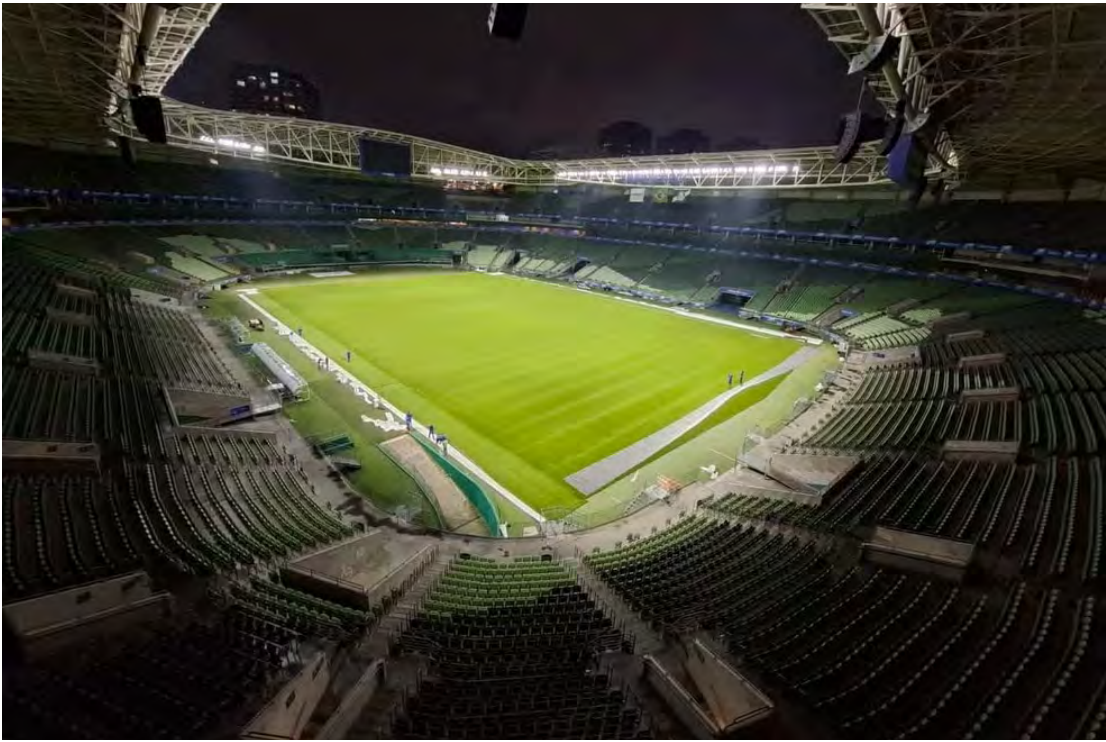
Trabalhos no Allianz Parque avançam para que estádio possa receber possível final do Campeonato Paulista
