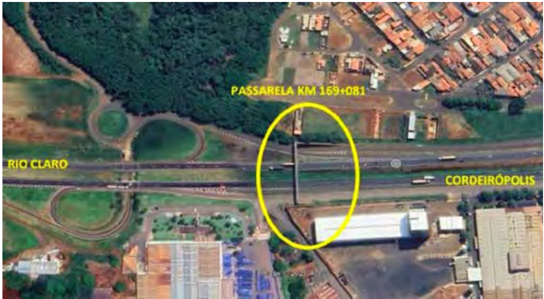
Intervenção na Rodovia Washington Luís exige interdição de marginal e faz parte das obras de adequação de passarelas
