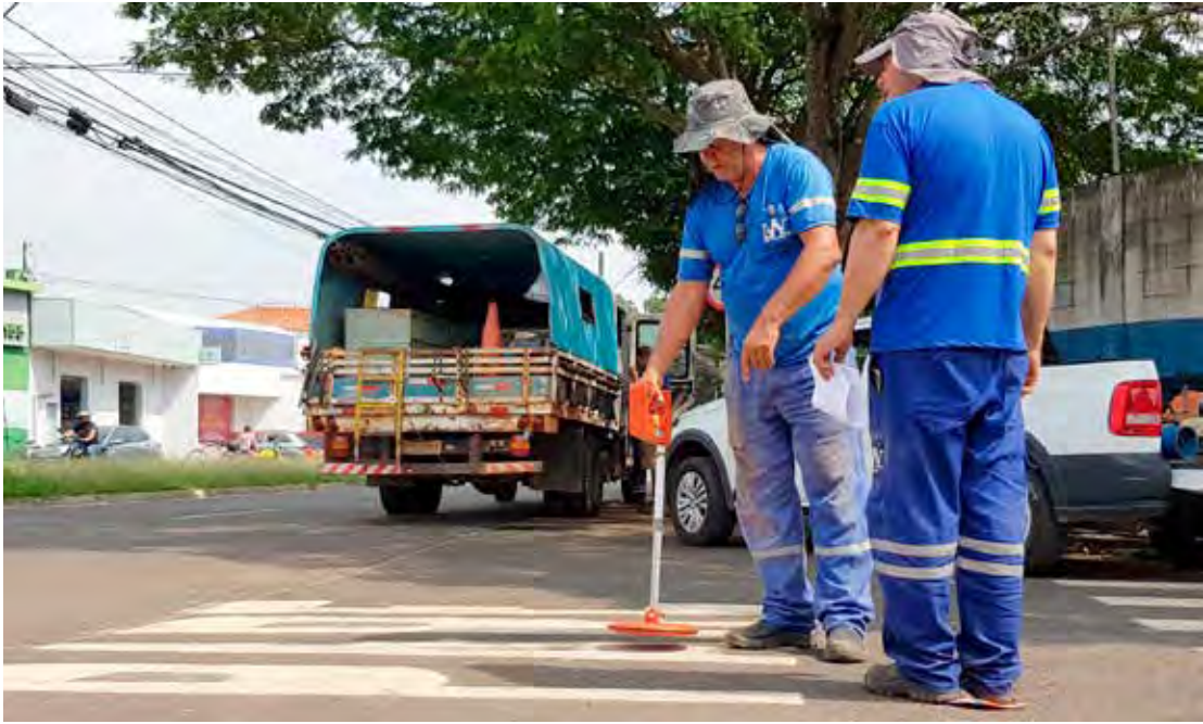
Reparo emergencial foi executado na segunda-feira (16) em adutora de 150 milímetros
