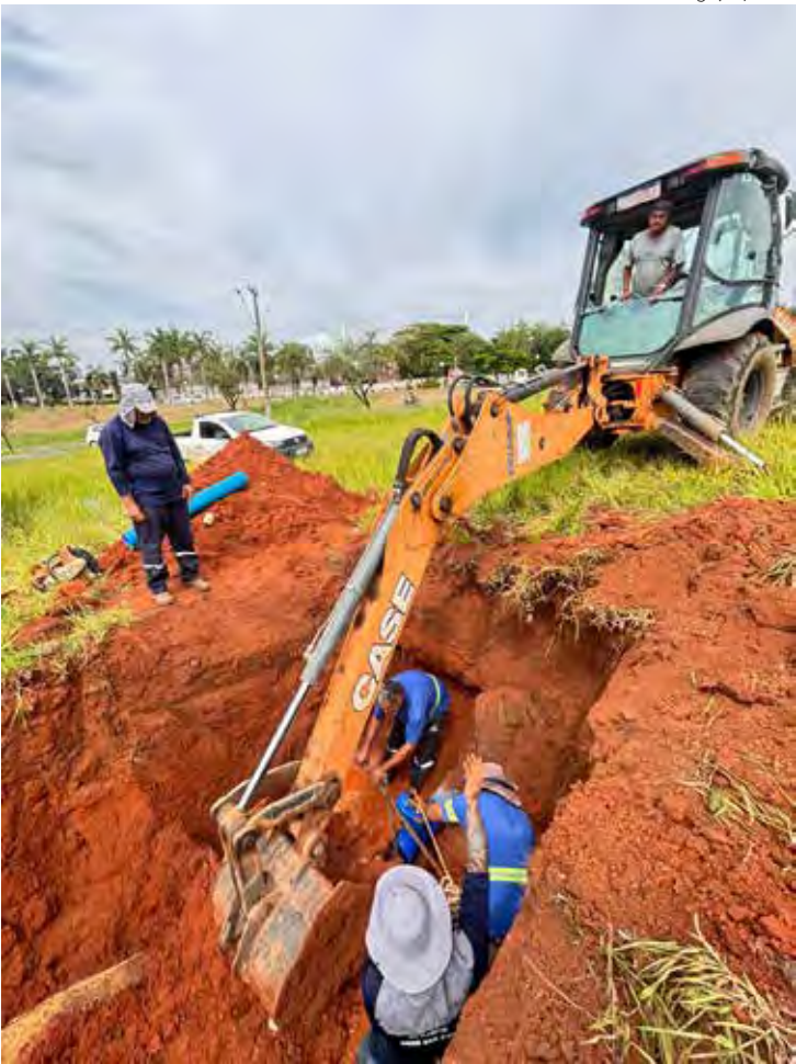
O Daae fez a troca de registro no canteiro da Avenida Ápia, com a Rua 1JC
