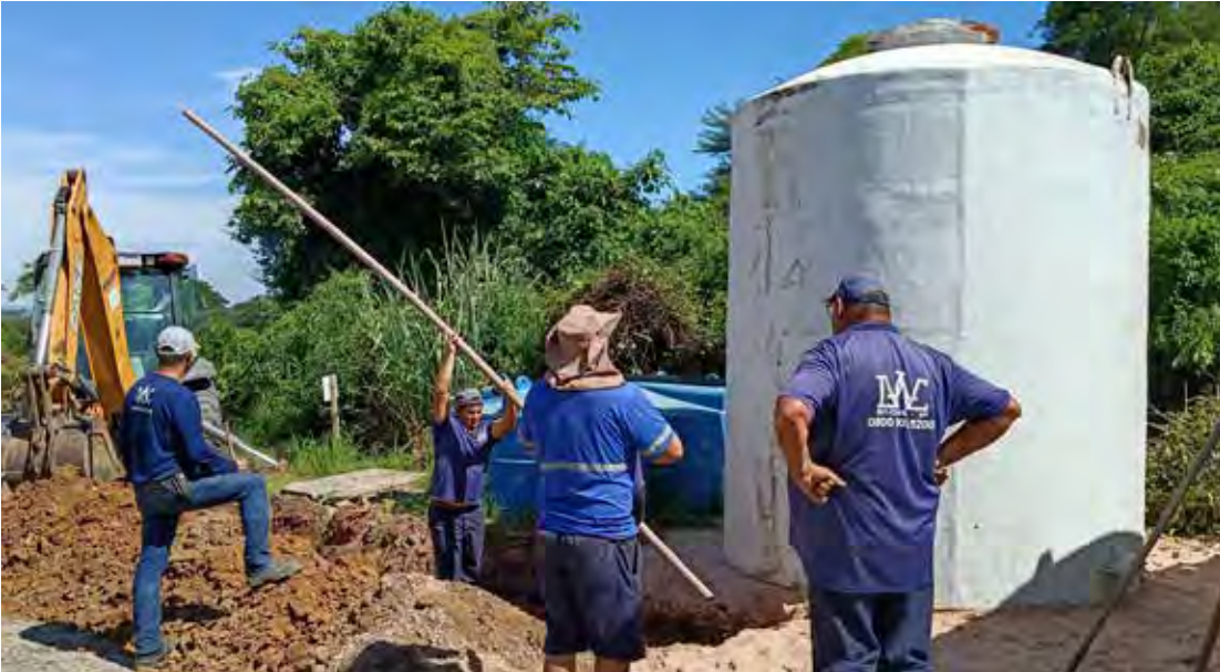
Autarquia fez manobras na rede e instalou mais um reservatório no distrito
