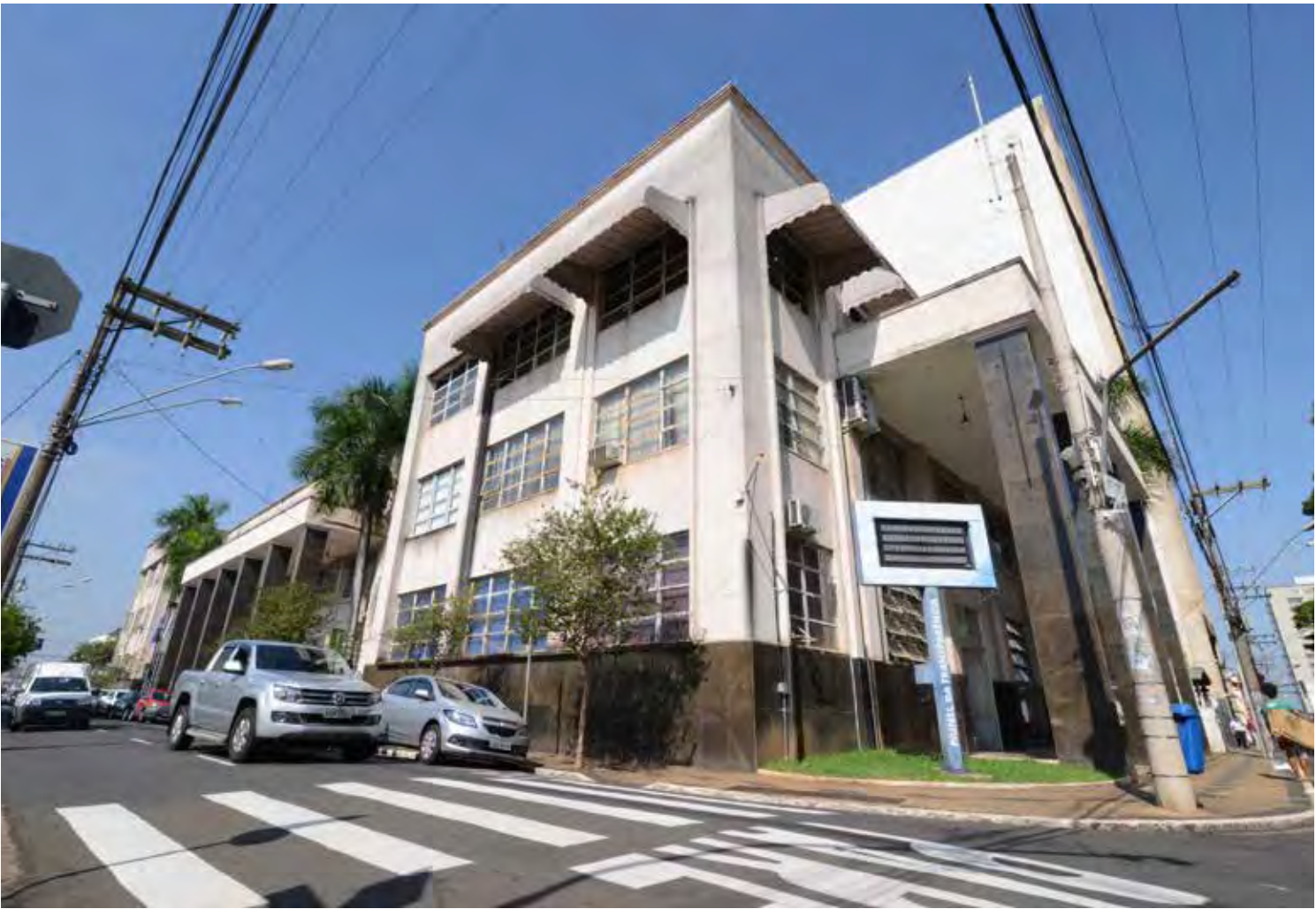
Totem antigo do Portal da Transparência que ficava em frente ao paço municipal
