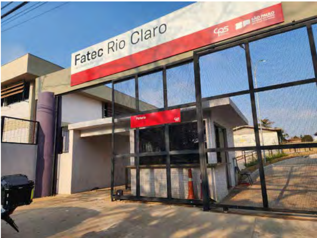
Fachada do prédio da Fatec que fica na Rua 2, no bairro Vila Operária
