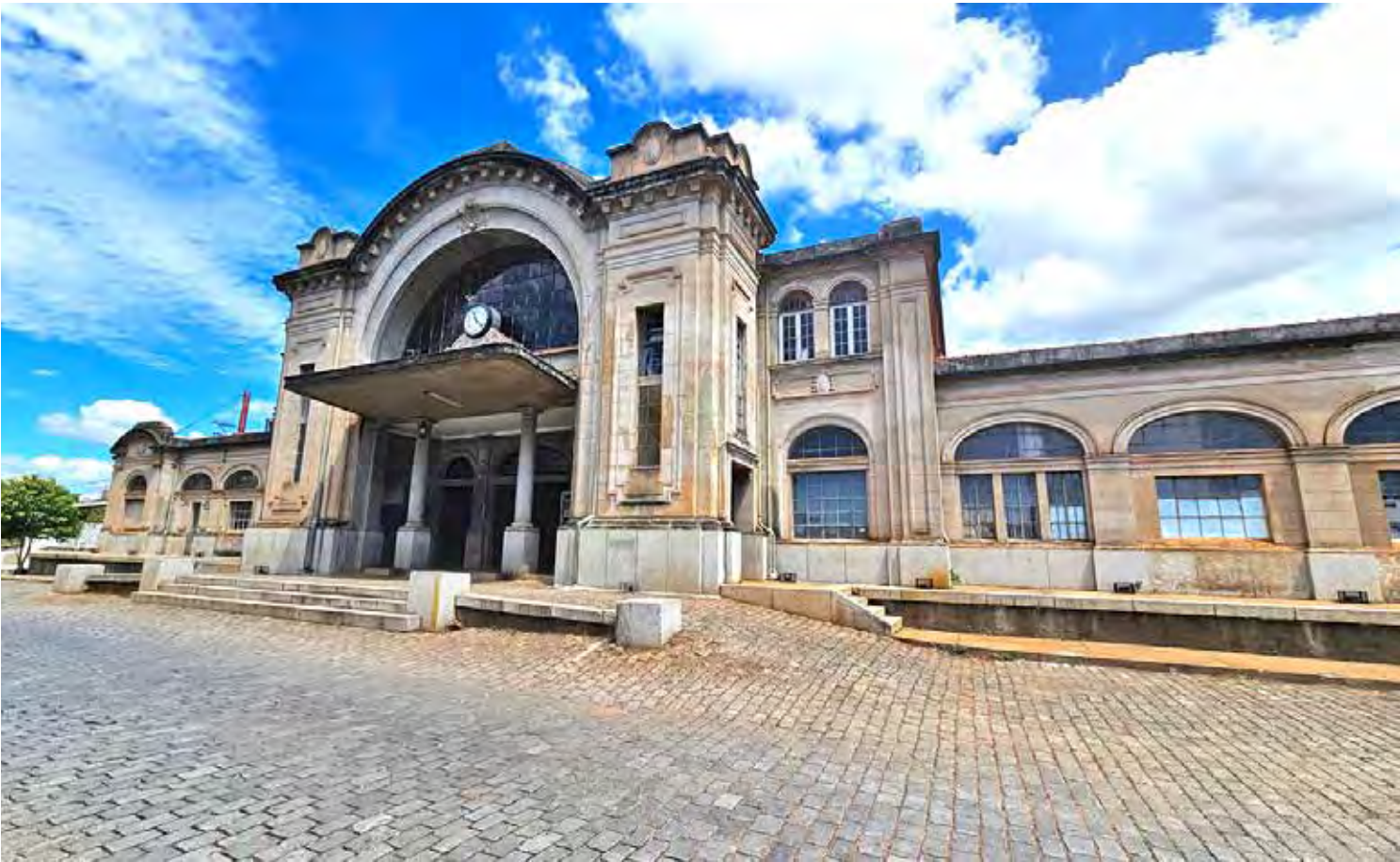
Estação Ferroviária em Botucatu-SP
