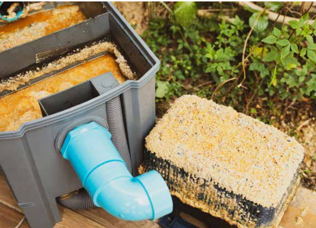
A empresa destaca que é obrigatório que todo imóvel tenha uma caixa de gordura ligada às tubulações da cozinha
