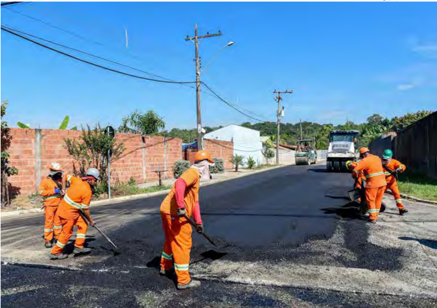
Mais trechos do Jardim Nova Rio Claro estão recebendo asfalto. O trabalho que a prefeitura está finalizando põe fim a mais de 30 anos de espera dos moradores do bairro, um dos poucos não tinham pavimentação. Página 6
