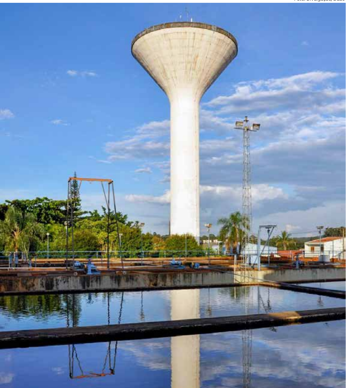
O sistema de Tratamento de água do município se constitui de duas estações: ETA 1 e ETA 2
