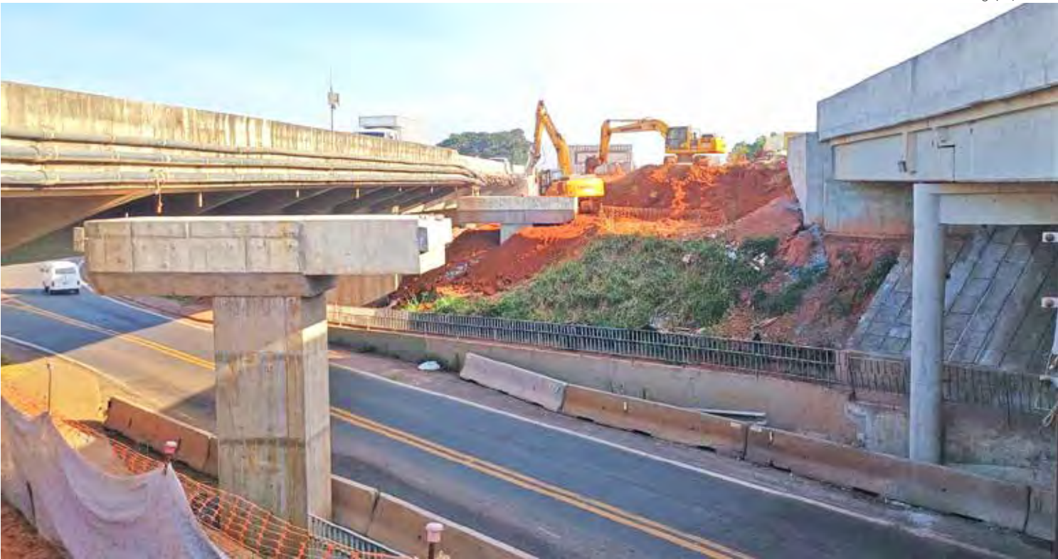
A interdição será utilizada para os serviços de demolição da laje e das barreiras do viaduto
