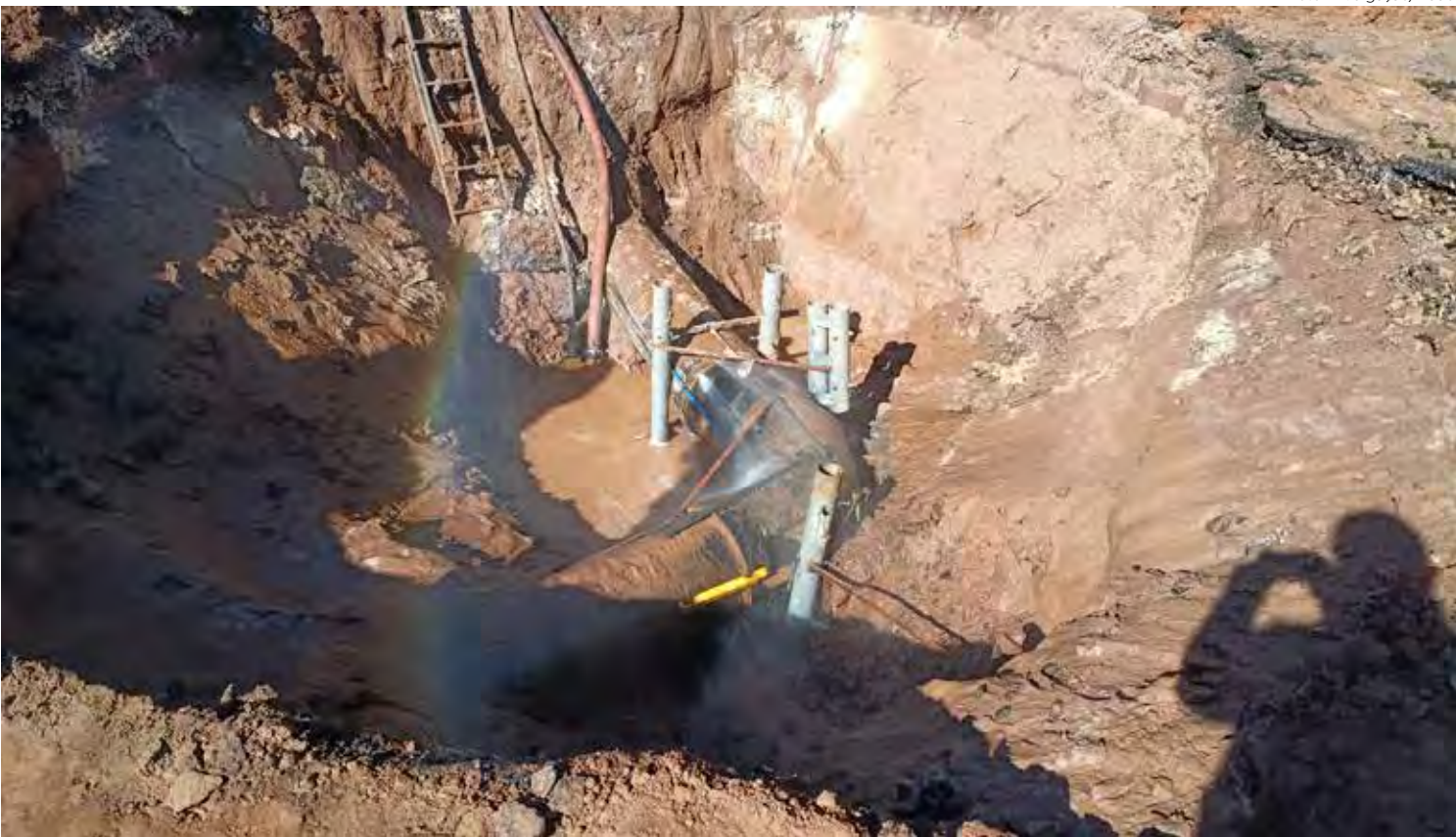
Equipe do Daae faz reparo na adutora localizada na rotatória da Rua 14
