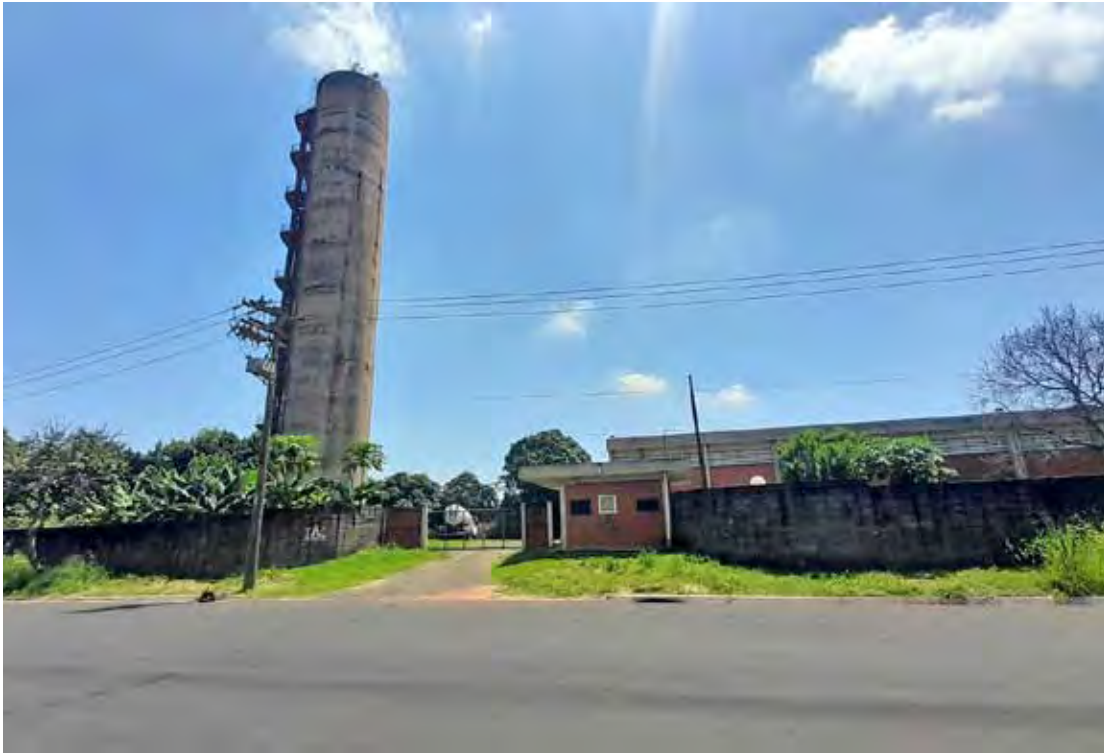
Central de Distribuição precisará ser temporariamente desligada, afetando bairros das regiões do Cervezão e Santa Clara
