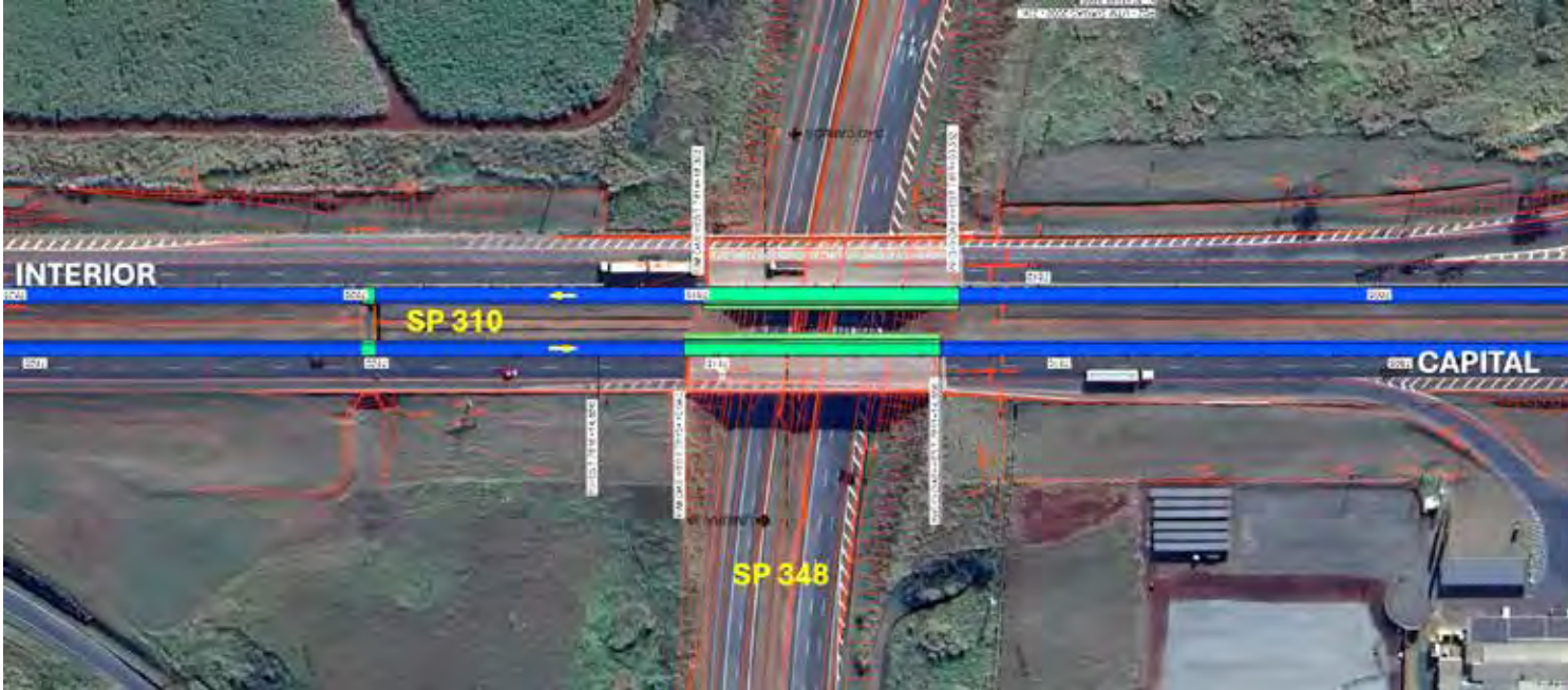
As intervenções ocorrem na altura do km 155 da S)-310, no viaduto sobre a SP-348
