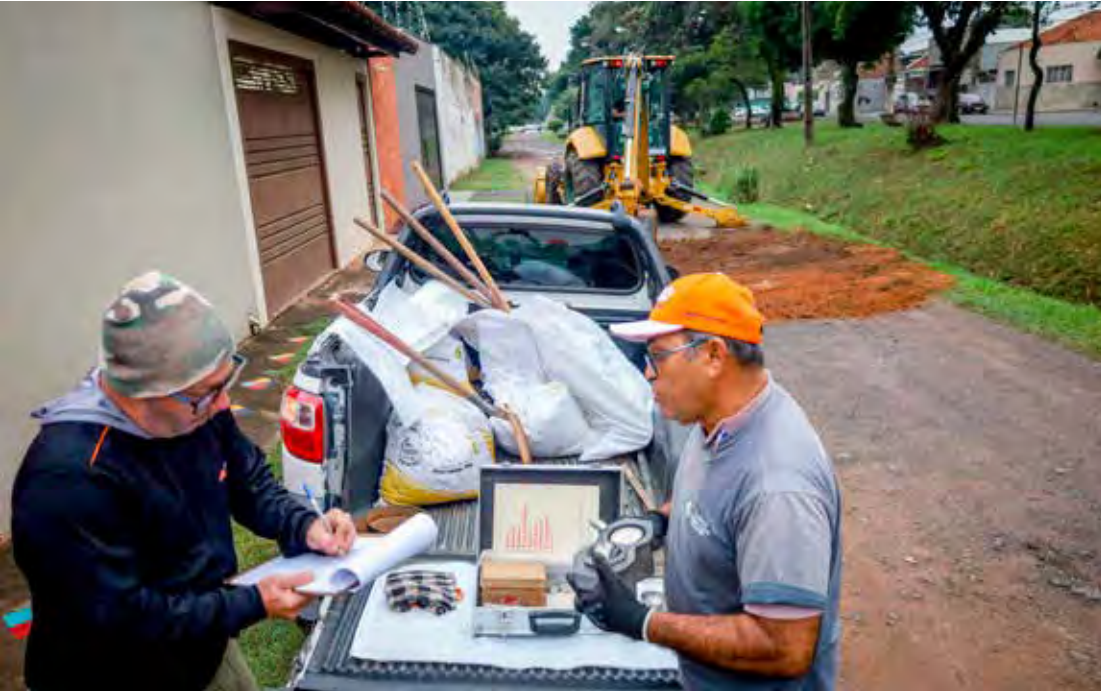
A prefeitura obras iniciou a marcação topográfica e sondagem de solo entre a Avenida 24 e a Avenida 32
