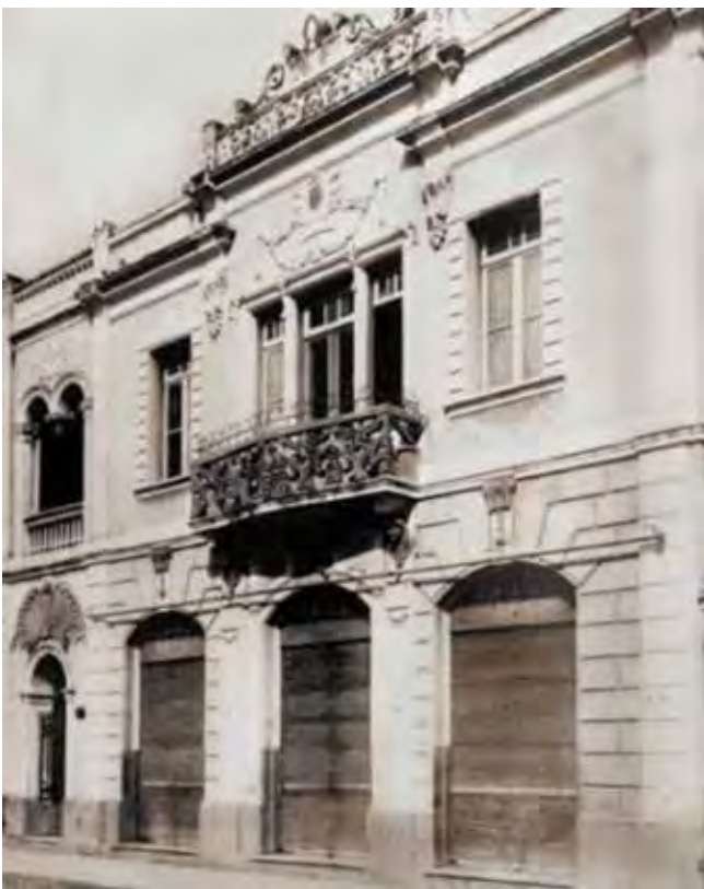
Prédio antigo da Acirc na Rua 3, região central de Rio Claro
