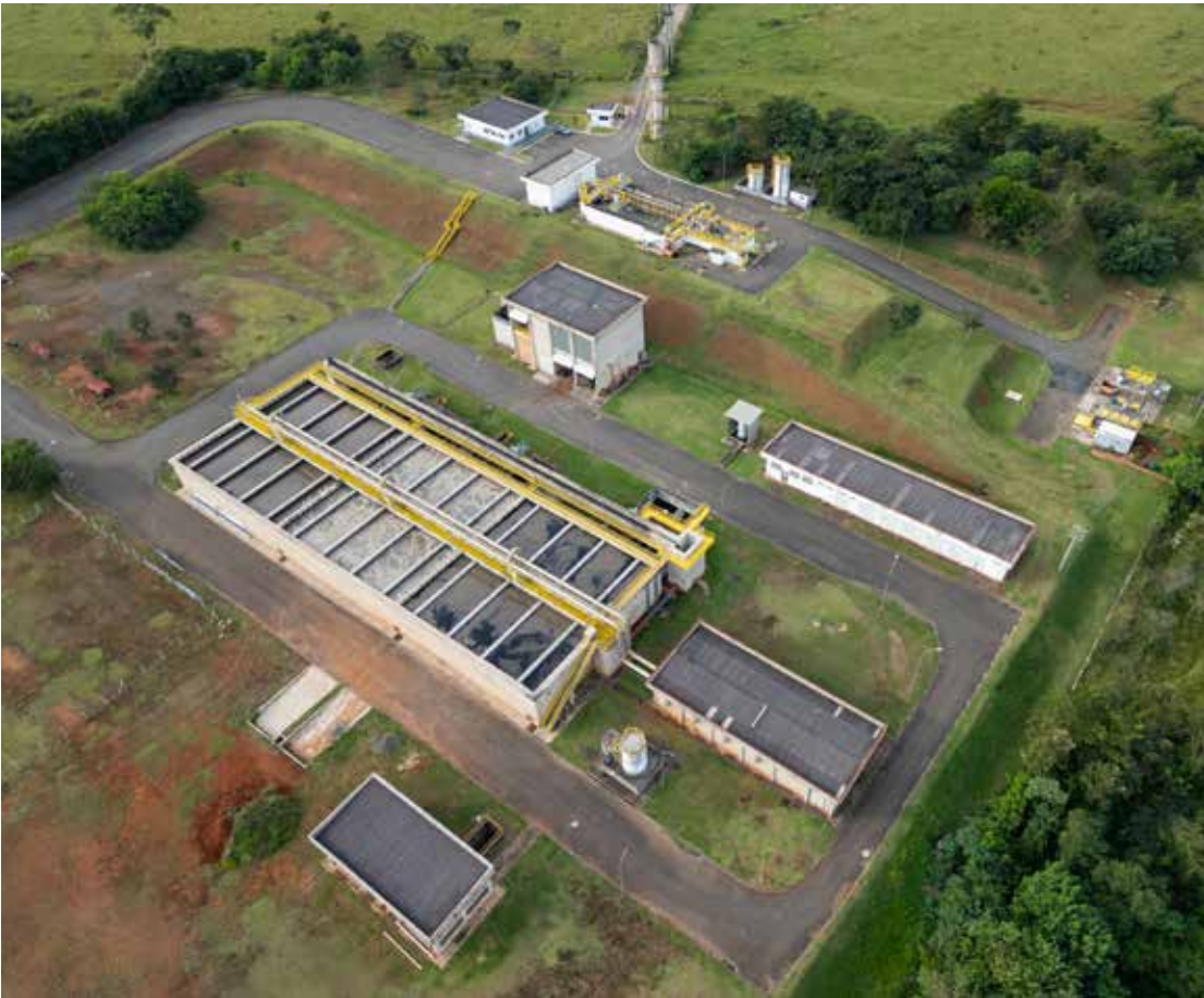
Estação de tratamento de esgoto do Jardim Novo, em Rio Claro
