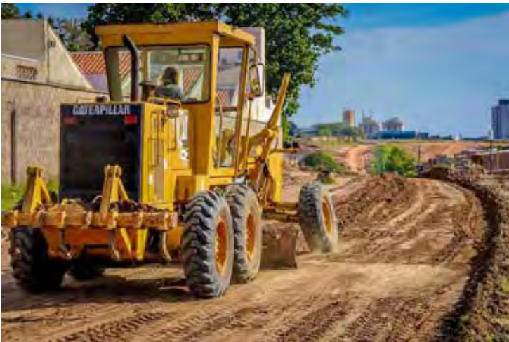
Ampliação da avenida deverá ser concluída até o início do ano que vem
