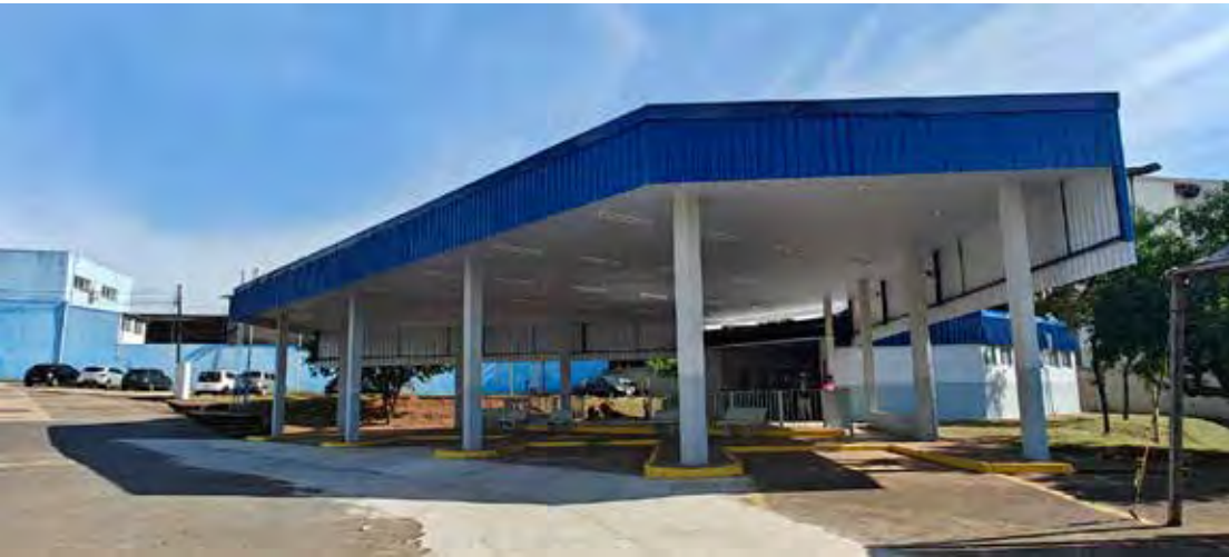
A rodoviária municipal foi reformada e revitalizada pela prefeitura
