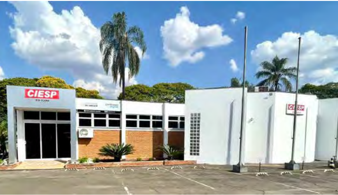
Fachada do prédio do Ciesp Rio Claro na Avenida President Kennedy, 900
