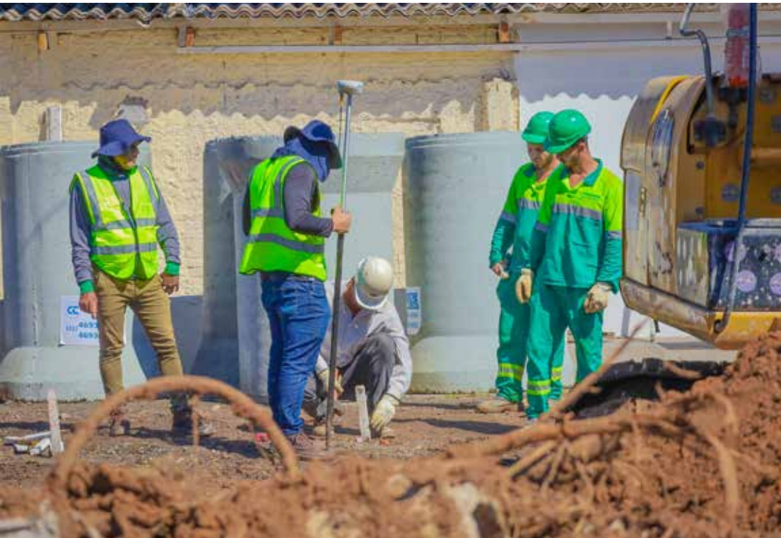
A obra de drenagem em trecho da antiga linha férrea paralelo à Rua 3-faz parte dos trabalhos de implantação da Avenida Integração
