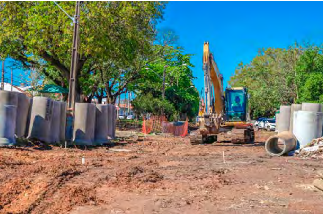
Fechamento do acesso à via é necessário para obras de infraestrutura da Avenida Integração
