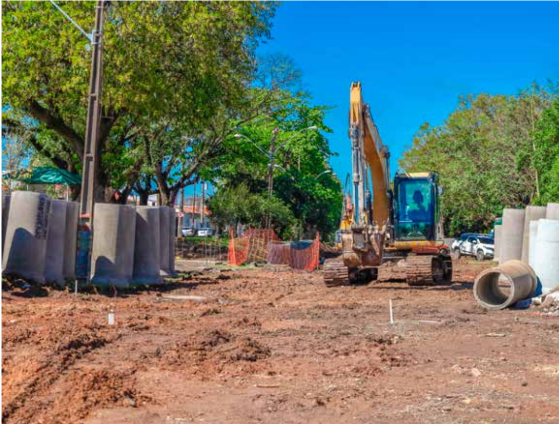
Fechamento do acesso é necessário para obras de infraestrutura da Avenida Integração
