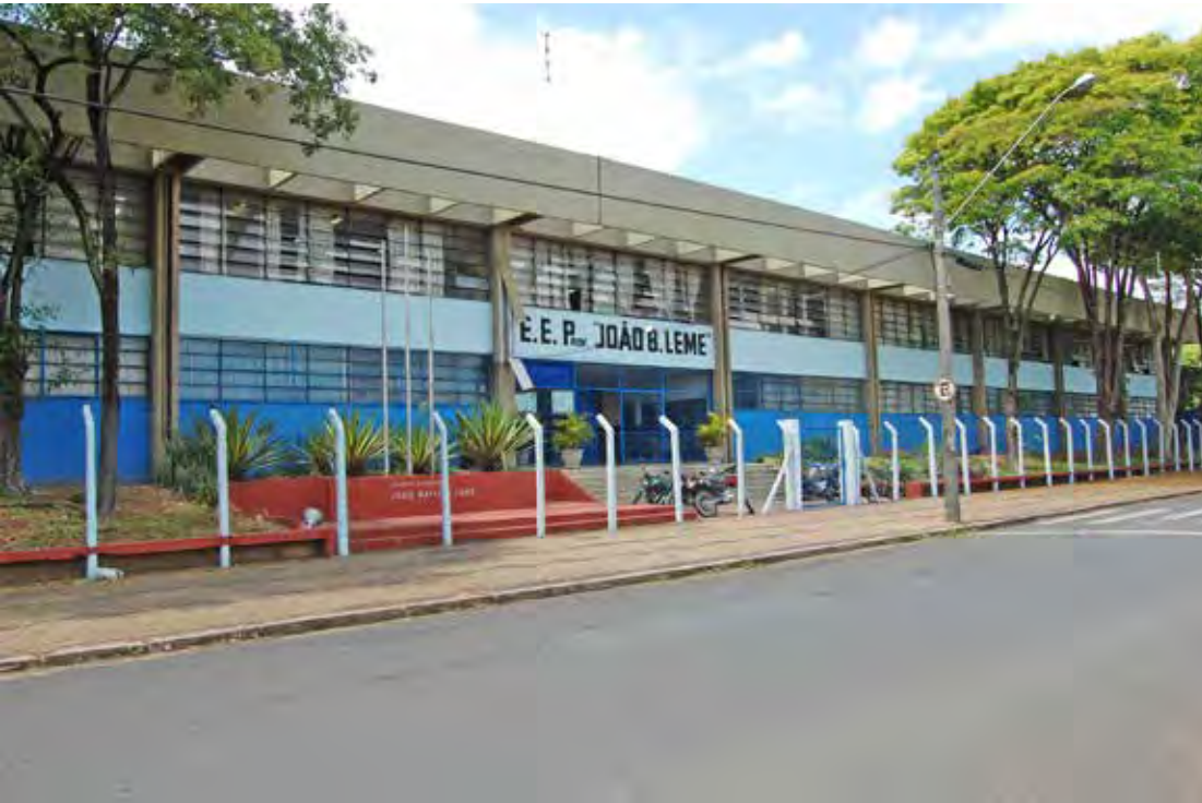
Fachada do prédio da escola Prof. Batista Leme
