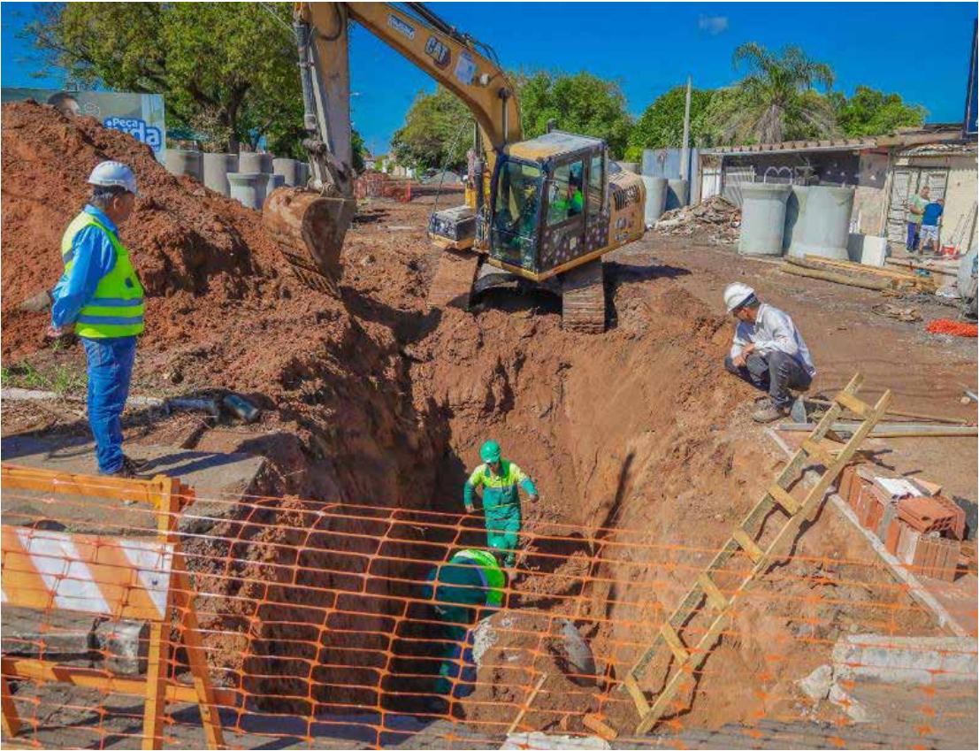
Fechamento é necessário para realização de obras de infraestrutura na futura Avenida Integração
